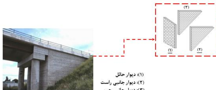
شکل ۶: بخش‌های اصلی قطعه کوله پل
