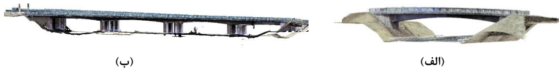
شکل ۱۰: نمای کلی داده مطالعاتی پل شماره یک (الف) و پل شماره دو (ب)
