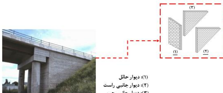
شکل ۶: بخش‌های اصلی قطعه کوله پل
