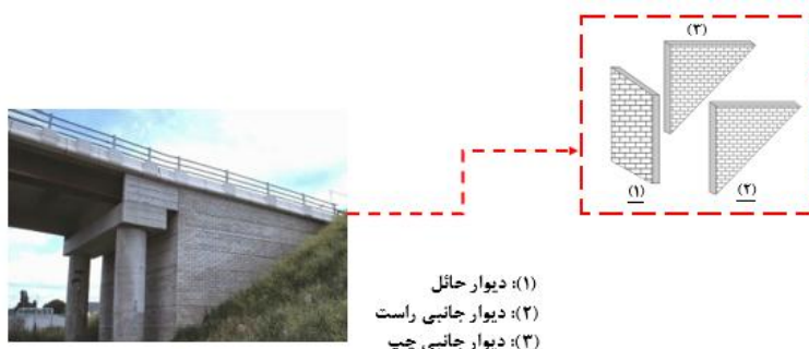
شکل ۶: بخش‌های اصلی قطعه کوله پل
